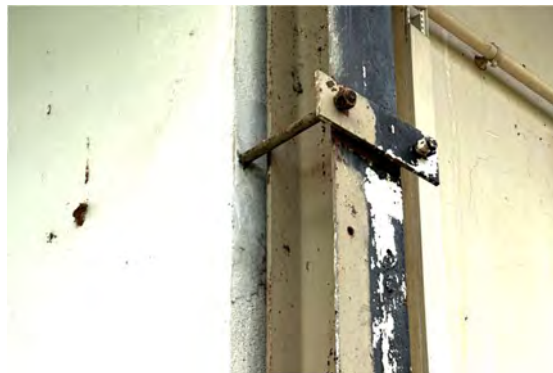
Brides contre maçonneries
