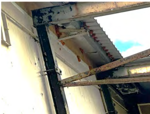
Contreventements dans le plan horizontal
