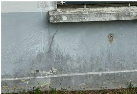
Zone 1 – fissure sous fenêtre
