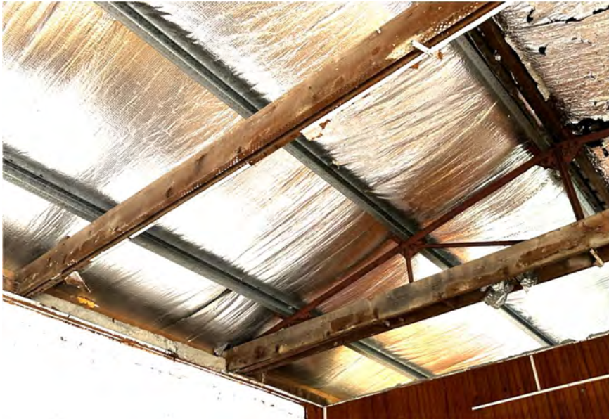
Poutraison transversale des plafonds haut de la salle principale
