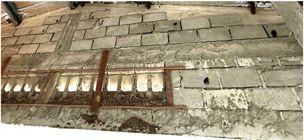
Vue sur pignon Est : maçonnerie grossière et béton peu fermé.
